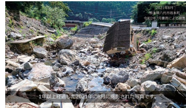
豪雨災害から1年以上経過した熊本県八代市坂本町の様子。家が流されており、災害の恐ろしさと、この地域の復興状況が読み取れます。これには坂本町の高齢化率の高さなどが背景にあります。
